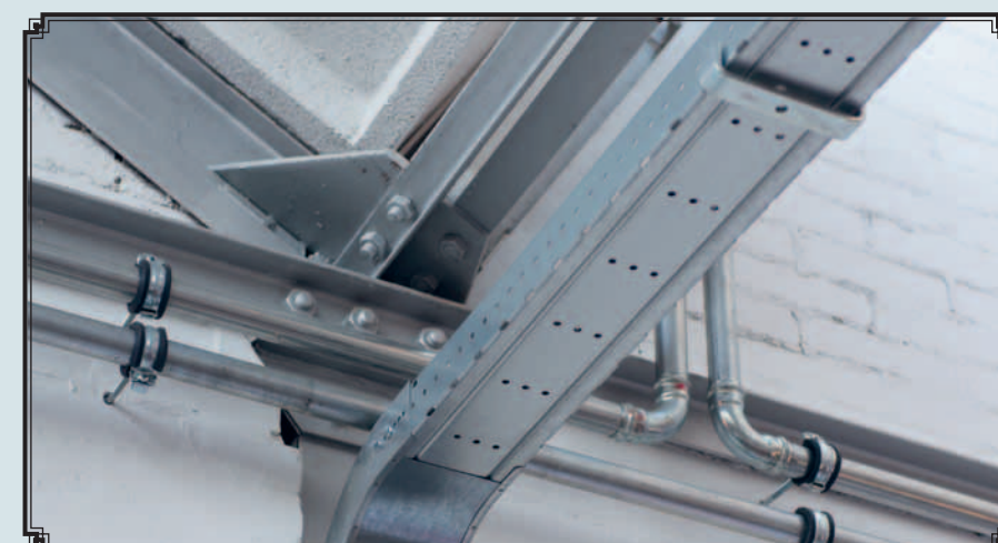
DE ORIGINELE STAAL BOUWCONSTRUCTIE ...
